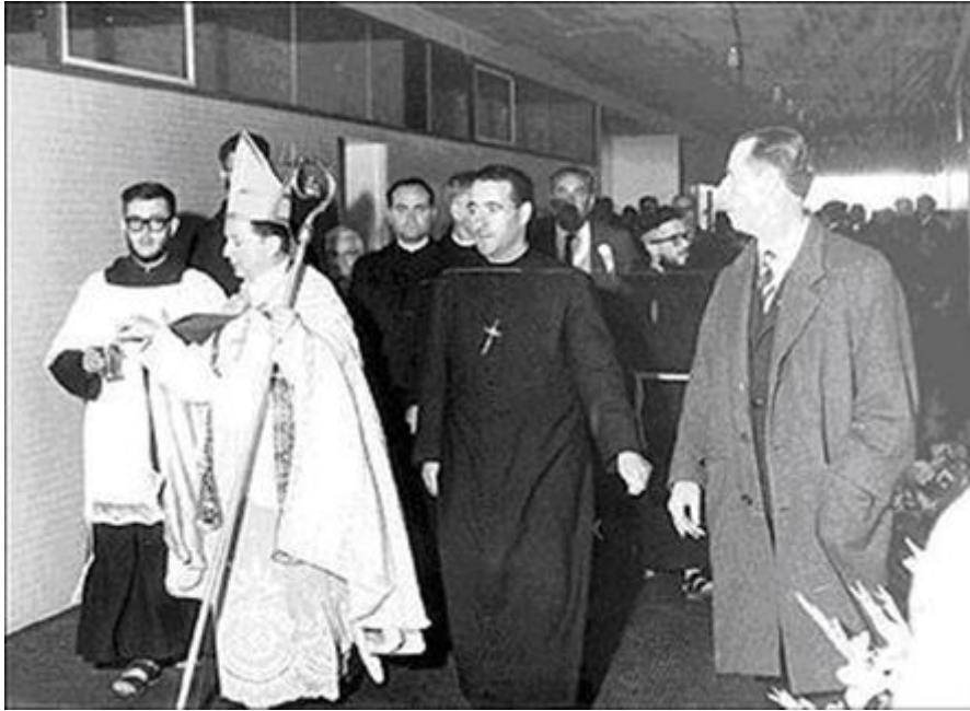
El Nuncio Apostólico Mons. Rafael Forni, bendice las nuevas instalaciones.
